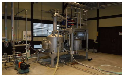
・食品工場 ・蒸留設備設置工事
