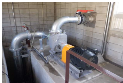
・和田揚水機改修工事
