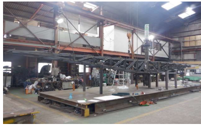
総廃シツクナー槽掻寄機
