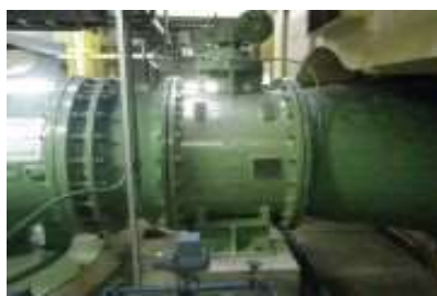
・臼杵市上北配水地築造工事 ・給水設備
