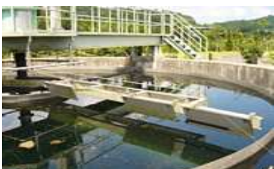
・臼杵市野津浄化センター ・最終沈殿地掻き寄せ機および歩廊製作据付
