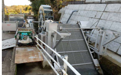
・竹田市城原 ・除塵機製作工事
