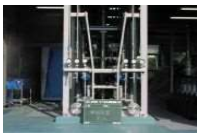
・陸上自衛隊湯布院駐屯地 ・給水膜ろ過設備
