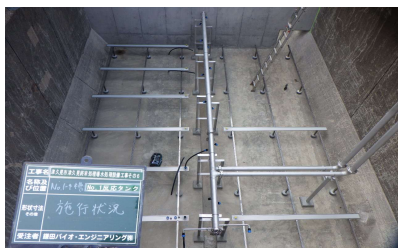
・津久見終末処理場 ・散気装置更新工事
