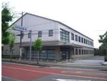
空調給排水工事
