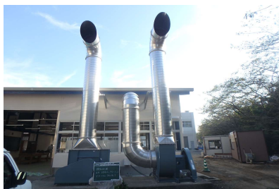
・海洋漁業実習棟 ・内外改造機械工事
