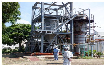
・別府終末処理場 ・水処理設備工事
