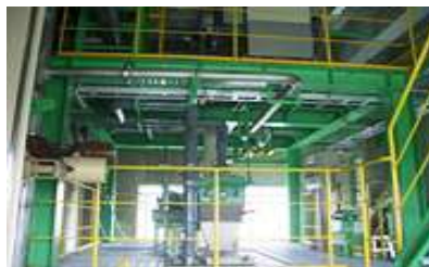
・臼杵終末処理場 ・架台製作据付工事
