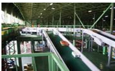
・製品搬送コンベアライン 製作据付
