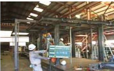
・日田終末処理場 ・汚泥脱水機架台製作
