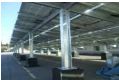
・ソーラー架台製作据付
