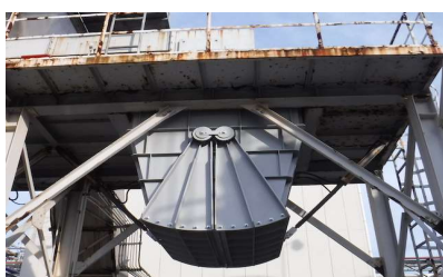
・ケーキホッパー製作工事
