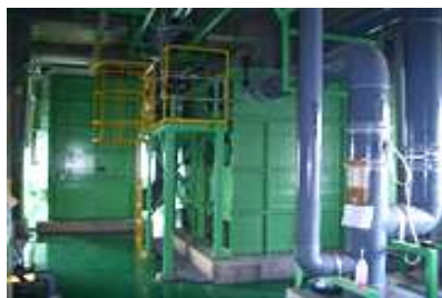
・臼杵終末処理場 ・架台製作据付工事・配管工事・機器据付工事
